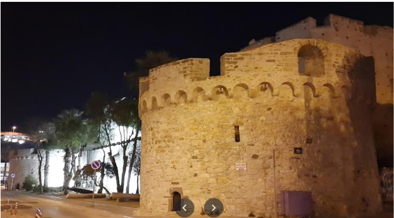
I bastioni genovesi della fortezza di Cesme. Foto tratta da Google Street View.
